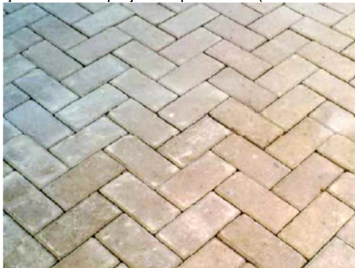
Figura 26: Piso com Bloco de Concreto Intertravado, assentado em espinha de peixe
